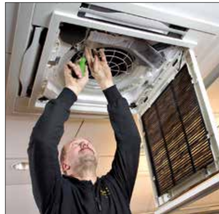
Med mindre rördimensioner kunde installationen av inredelarna enkelt utföras då hänsyn togs till andra installationer under samma tak. På bilden monteras en 4-vägs-kassetten i ett kontor.
