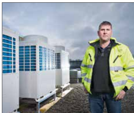
Peter Lembke, Rydell & Lembke Kyl & Värmeteknik AB, på taket hos Securitas Direct där utdelarna till VRF-systemet är placerade. De kör både tvårör- och trerörssystem, totalt 172 kW.
