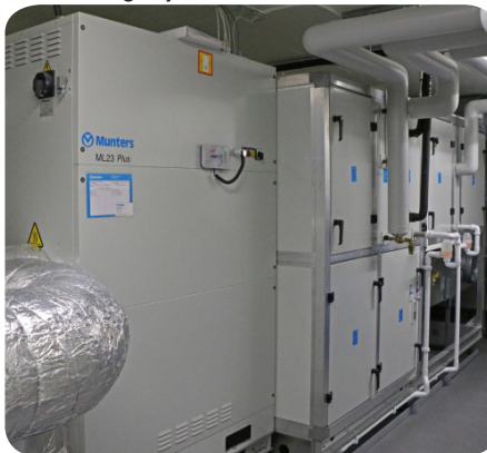
ML23 Plus klimatsystem med för- och efterbehandlingsmoduler.
