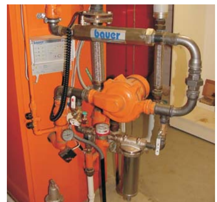
Installation direkt på röret
