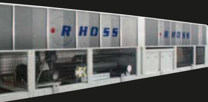
TCAVSZ 21600 ljuddämpad version "S" med koaxial- och tubpannevärmeväxlare, partiell kondensatorvärmeåtervinning med integrerad pumpgrupp
