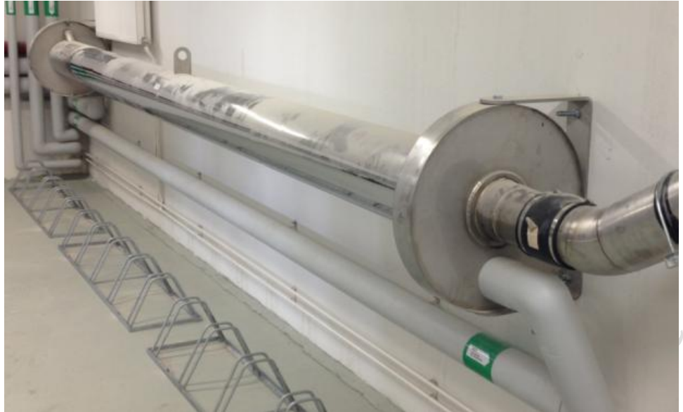
Figur 6.1 Liggande rörvärmväxlare (Foto: Anders Nykvist).
