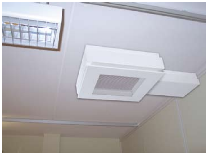
Exempel på installation av Parasol EX dikt an mot tak.
