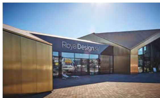
Mässingsväggarna känns som uppvikta på taket. Även ventilationsgallren från Hagab är specialritade i mässing för att hålla fasaden enhetlig.
