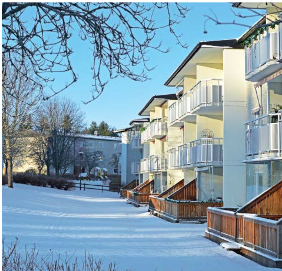
Bild: BRF Granen, Järfälla IMD El och MVC Foto: Lotta Lindström
